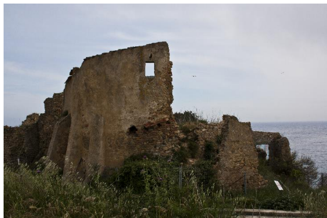
Vista desde el oeste
