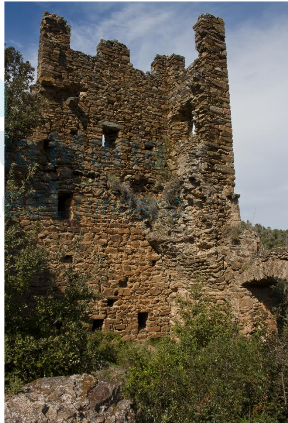
Torreón en el sector noroeste
