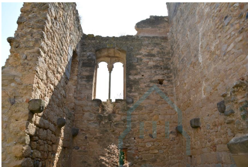
Restos del palacio episcopal
