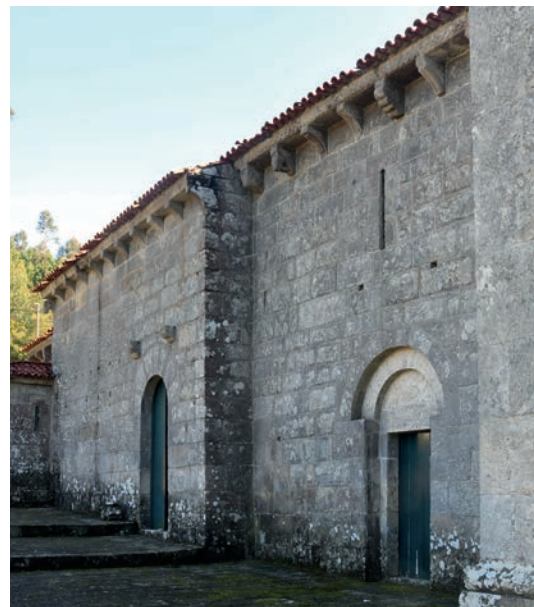
Alçado norte. Nave
