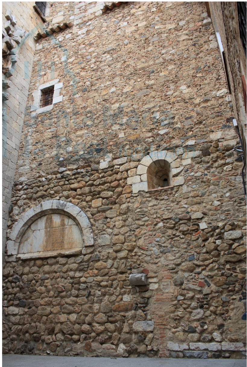
Detalle del muro sur
