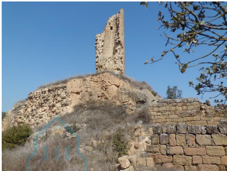
Vista general de la torre desde el sur
