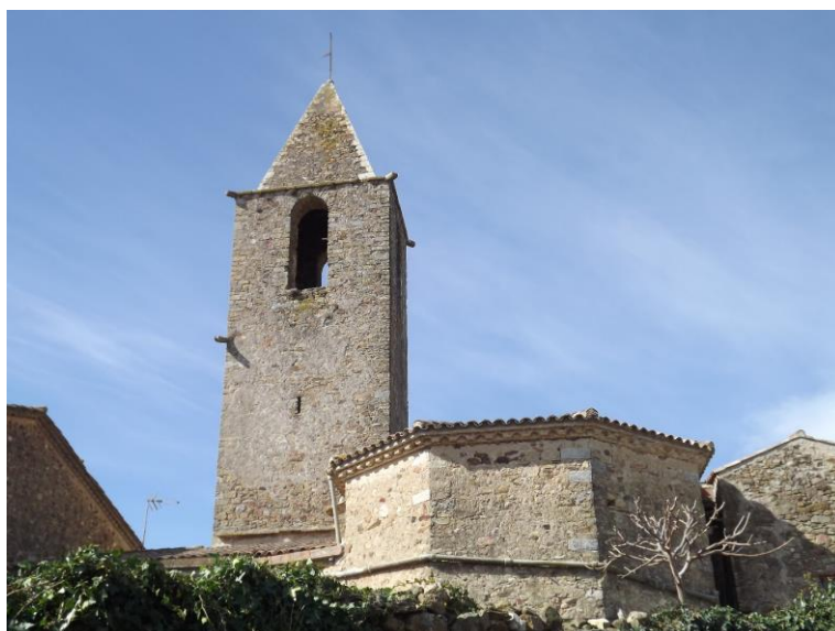
Cabecera y torre campanario
