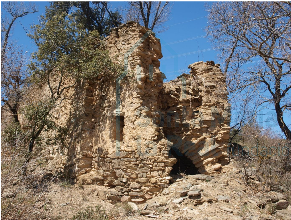
Restos del ábside
