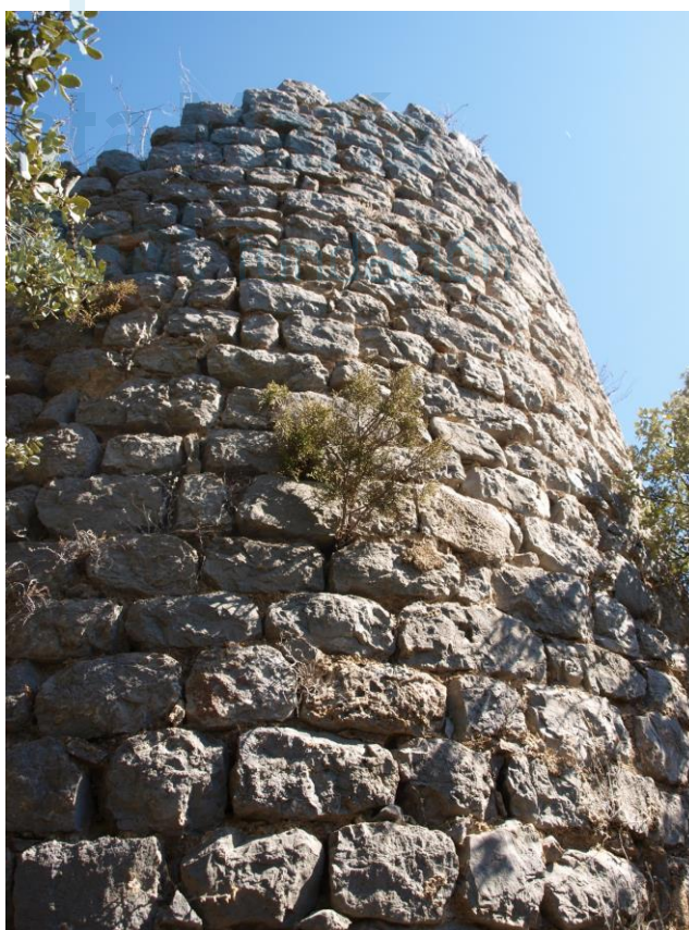
Restos de la torre
