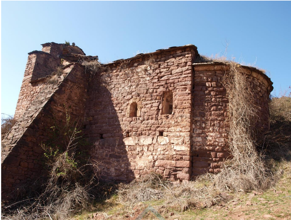
Ábside y muro sur
