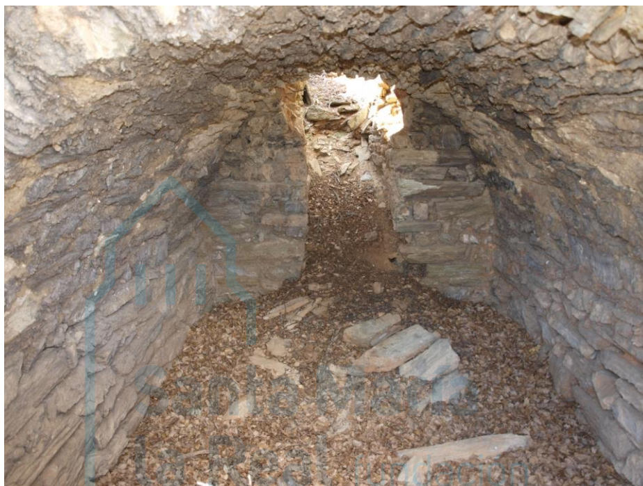
Interior de la cripta
