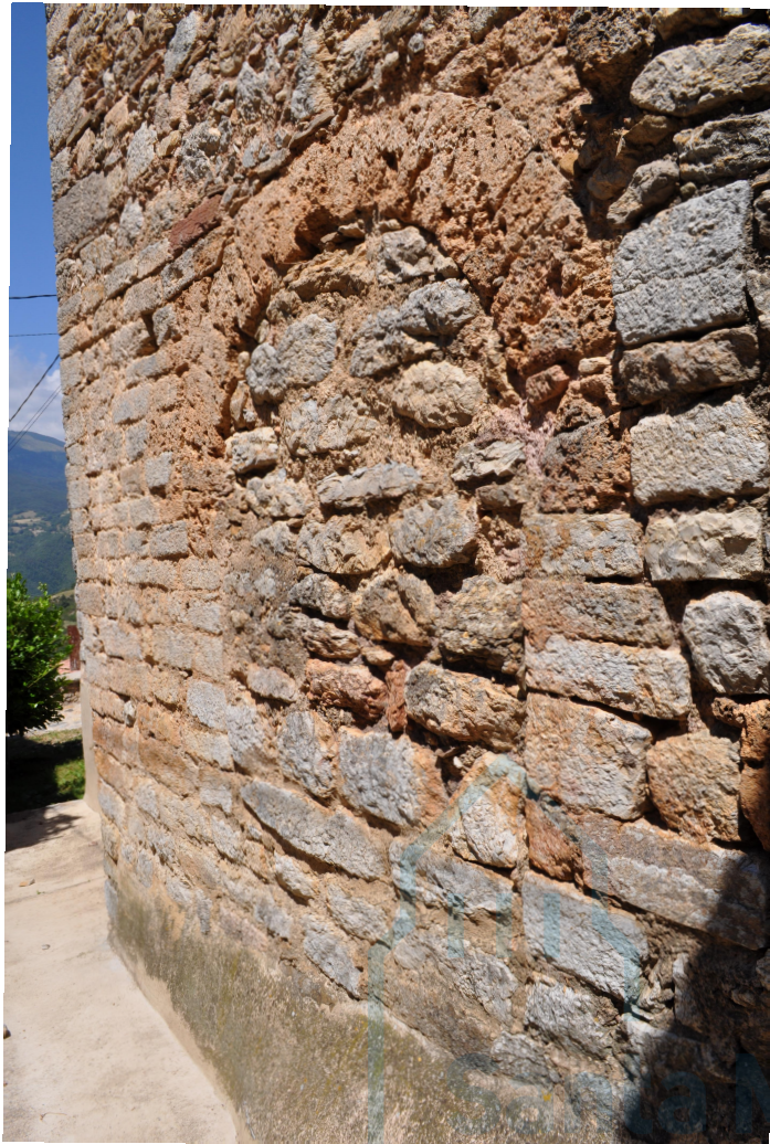
Paño de muro románico con puerta tapiada
