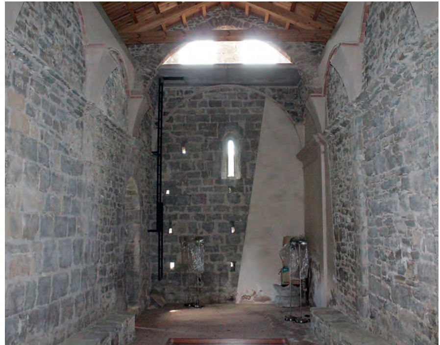
Interior hacia el Oeste
