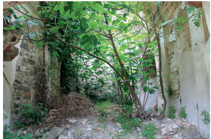
Estado actual del interior de la nave
