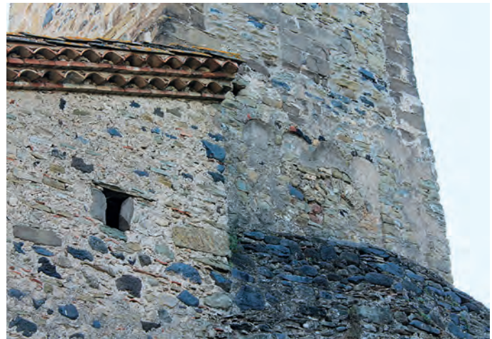
Detalle de las arcuaciones ciegas del campanario
