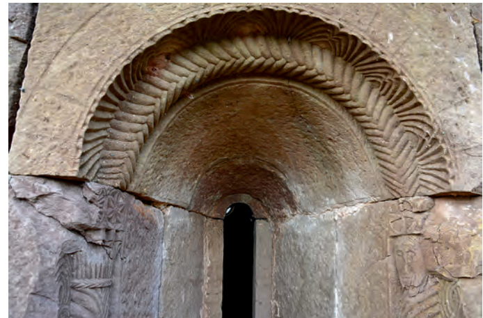
Detalle de la ventana central del ábside
