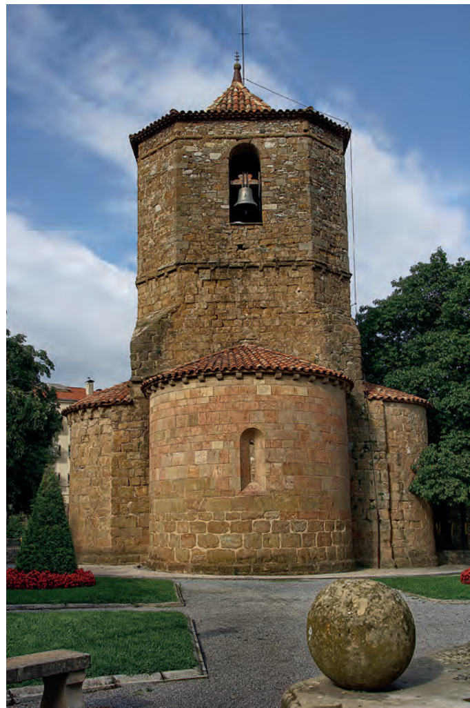
Vista del exterior de los ábsides y la torre
