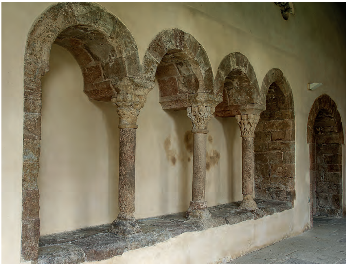
Arquería del claustro románico
