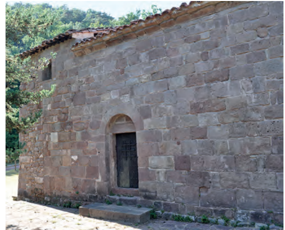
Fachada sur con puerta de acceso
