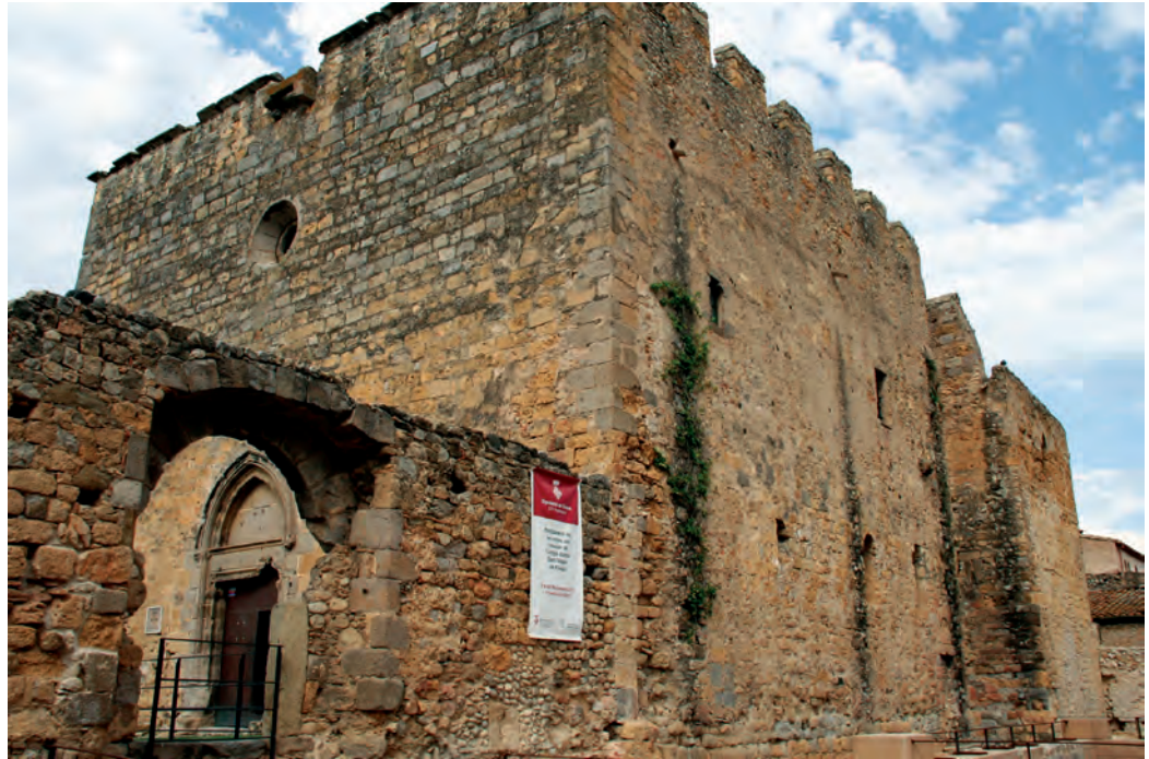
Vista del costat sud de l'església, amb aspecte de fortalesa
