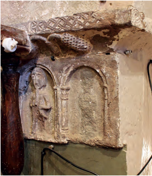
Imposta i relleu del mur meridional
