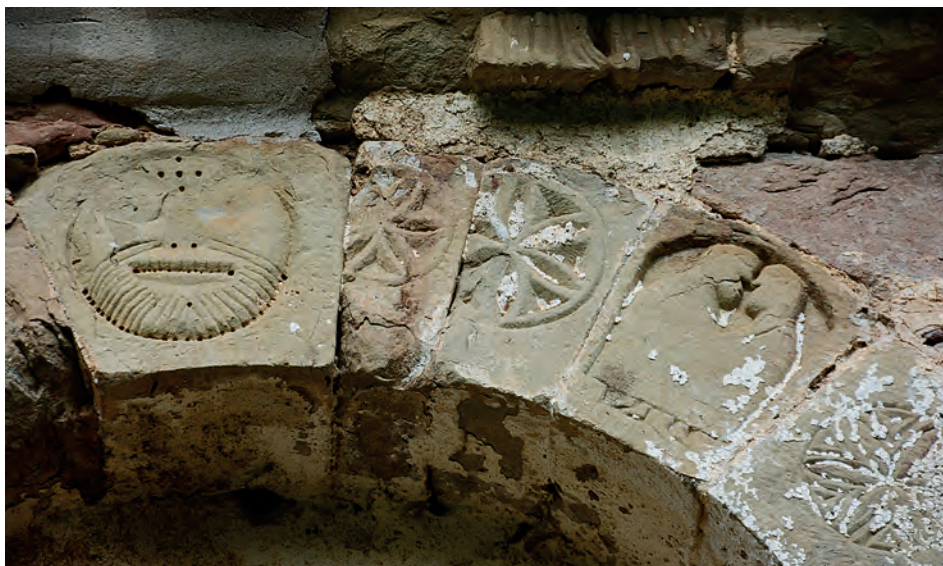
Finestra del mur sud: detall de les dovelles de l'arc
