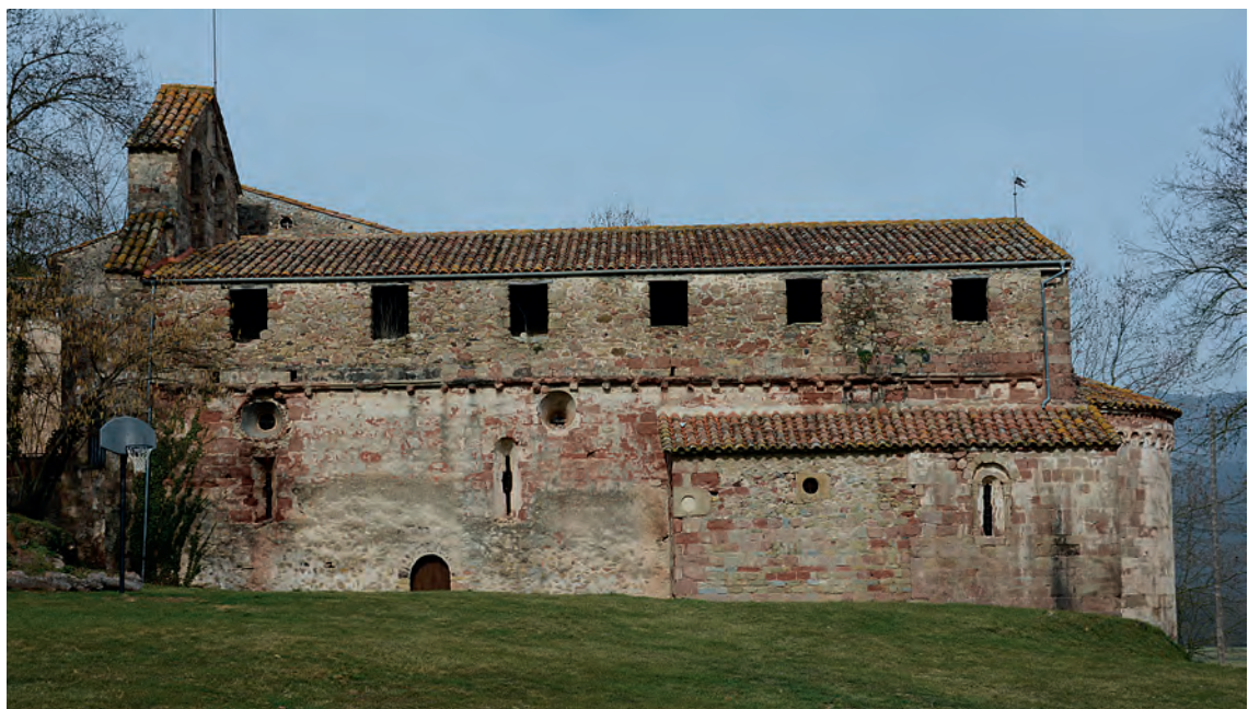
Vista del temple des del sud
