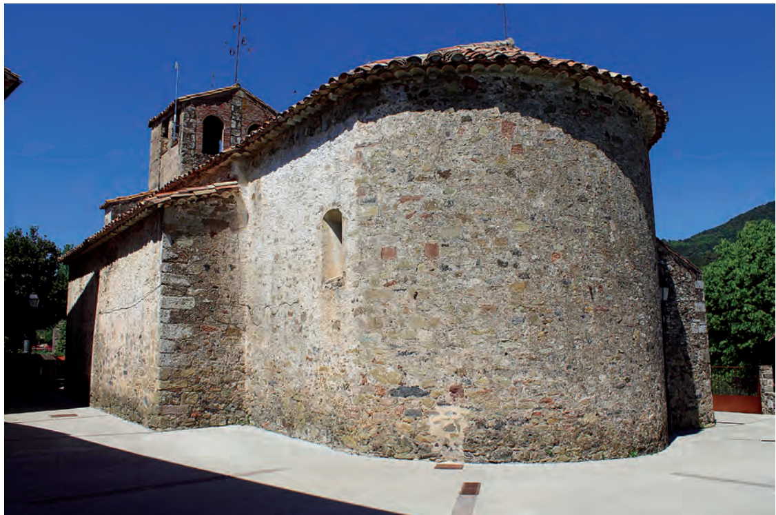
Vista exterior de la capçalera
