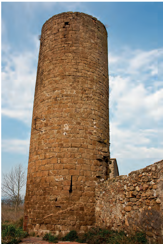
Vista de la torre
