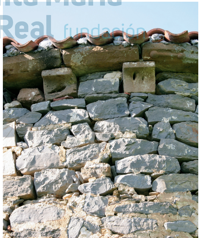
Detalle de los canecillos 5 y 6 del ábside
