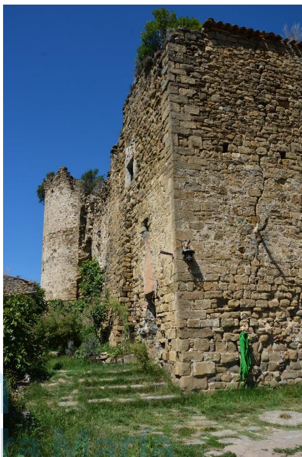
Detalle del muro sur y la torre
