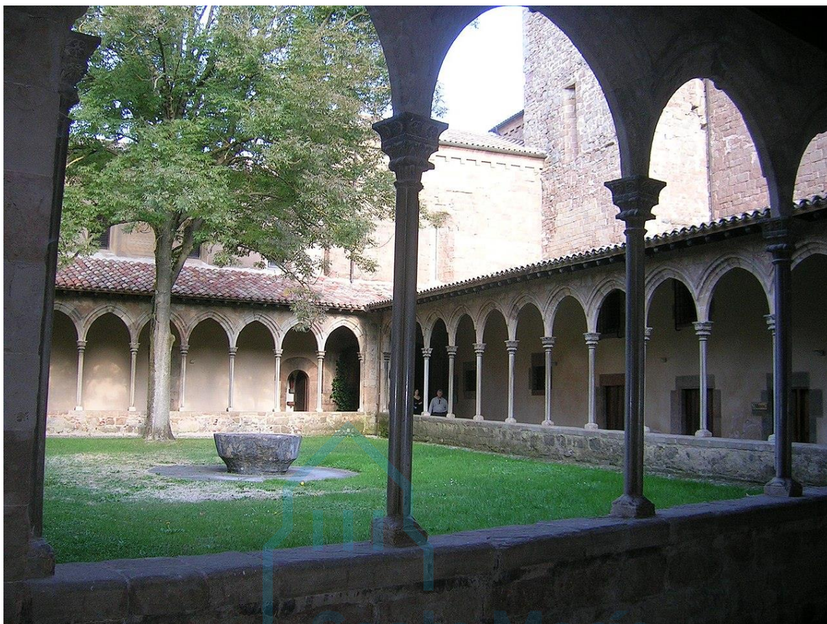
Vista del claustro
