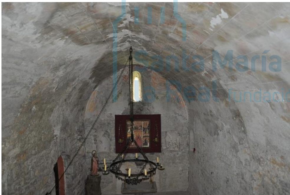
Bóveda del interior
