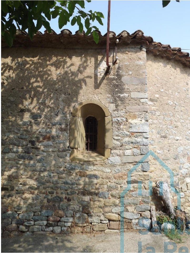
Detalle de la ventana en el muro sur
