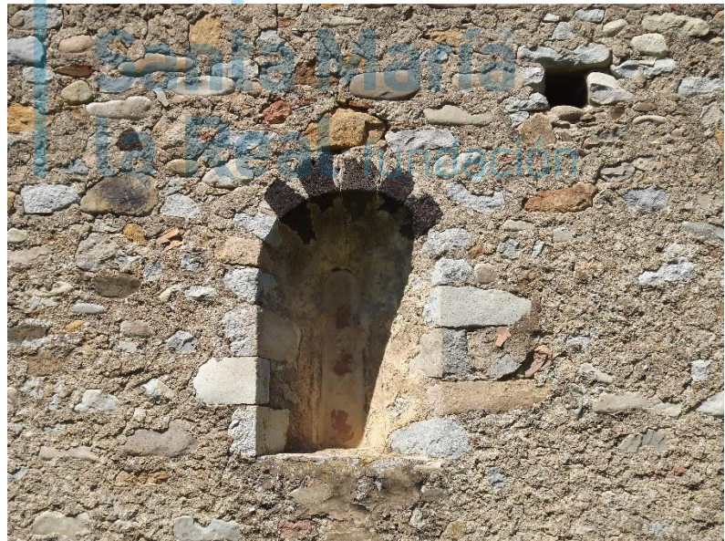
Detalle de la ventana tapiada
