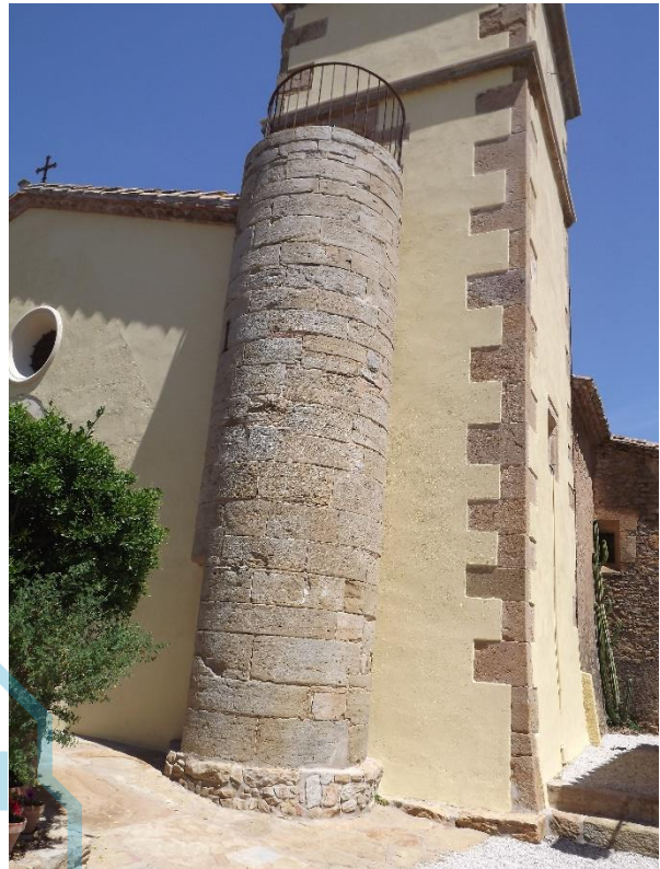
Vista exterior de la escalera que sube al campanario
