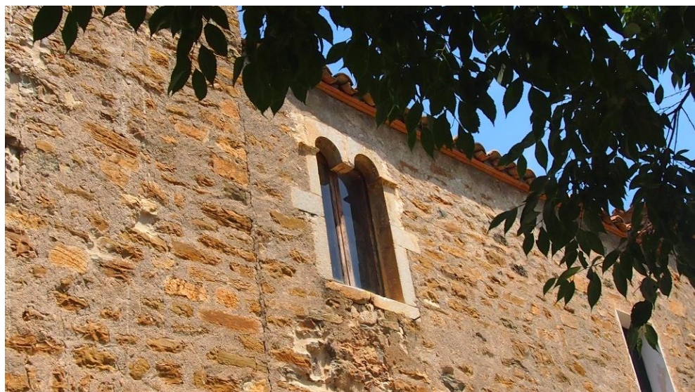
Detalle de ventana geminada
