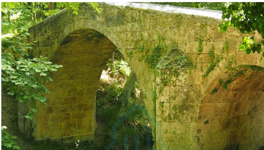
Vista del puente
