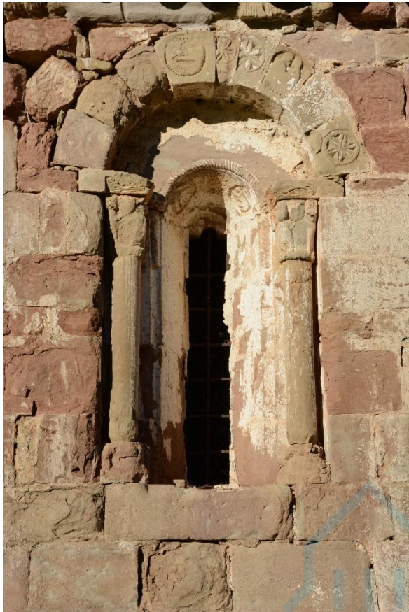
Ventana en el muro sur
