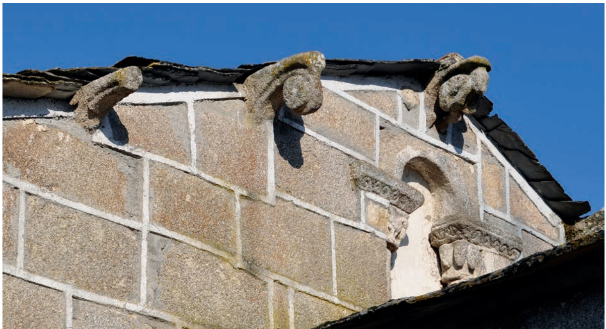
Canecillos del muro este de la nave
