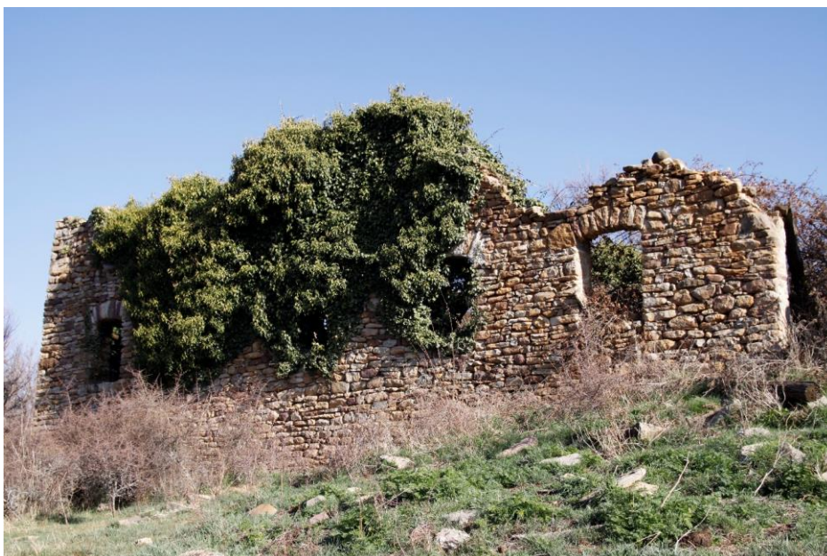
Vista de uno de los muros con ventanales
