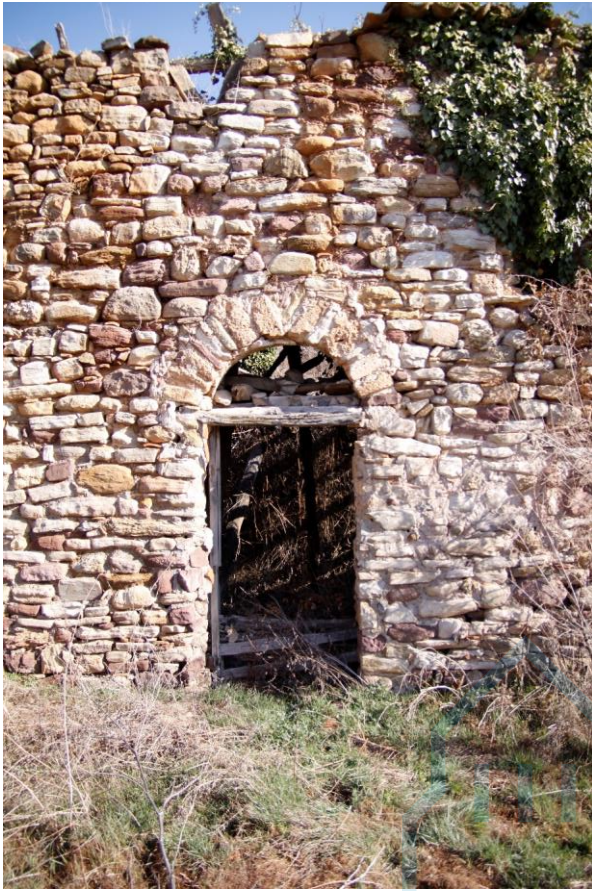
Detalle de la portada de la fachada meridional
