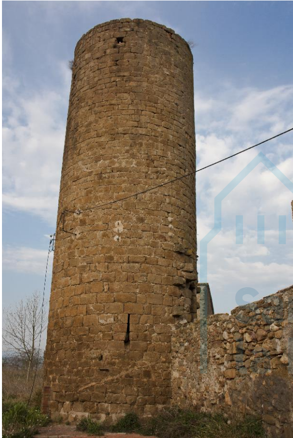
Vista de la torre
