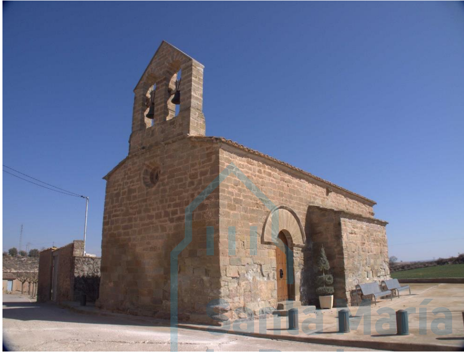
Fachada oeste y muro sur
