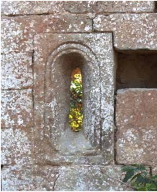
Ventana en el muro norte
