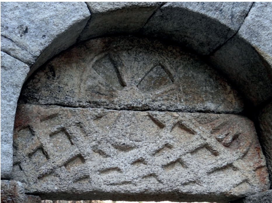
Tímpano do vão aberto em muro adossado à fachada principal
