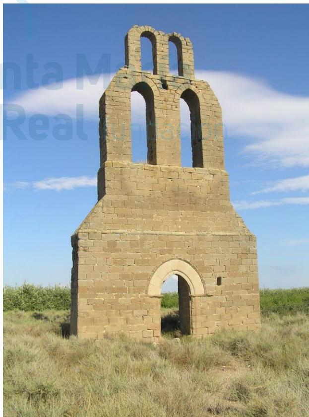
Restos de la fachada oeste
