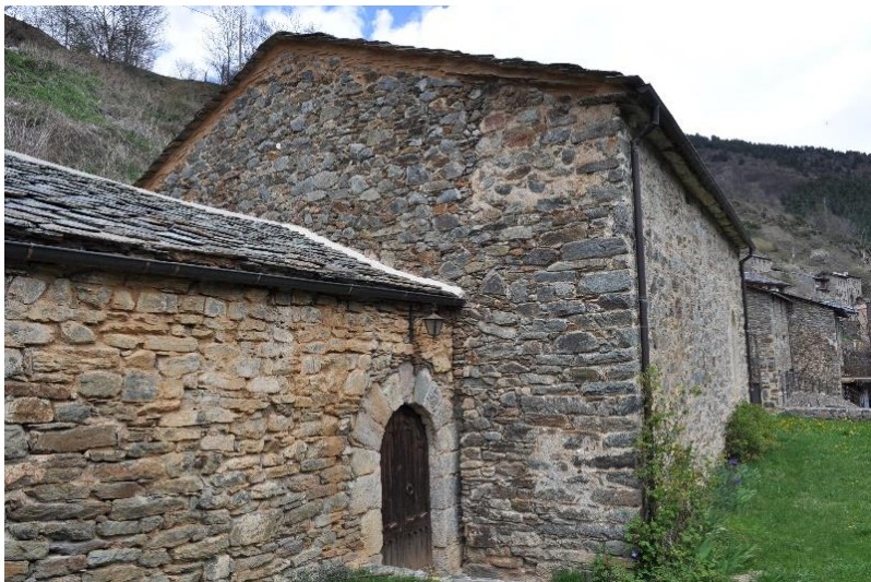
Vista de la nave románica y ampliación
