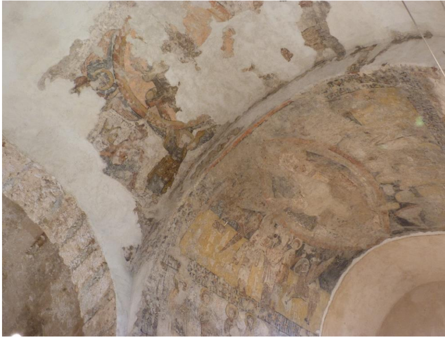
Vista general de las pinturas del ábside y el primer tramo de la nave
