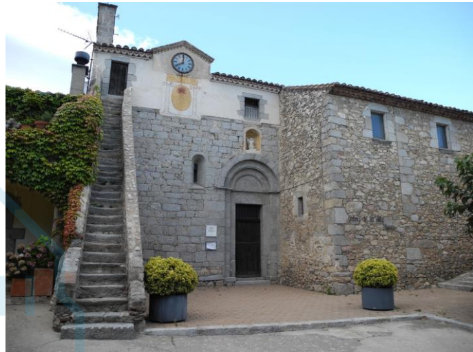
Vista de la fachada sur
