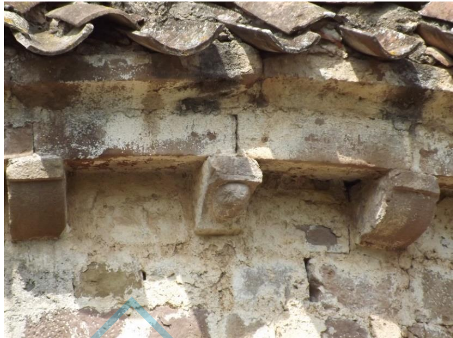
Detalle de la ménsula decorada en el ábside
