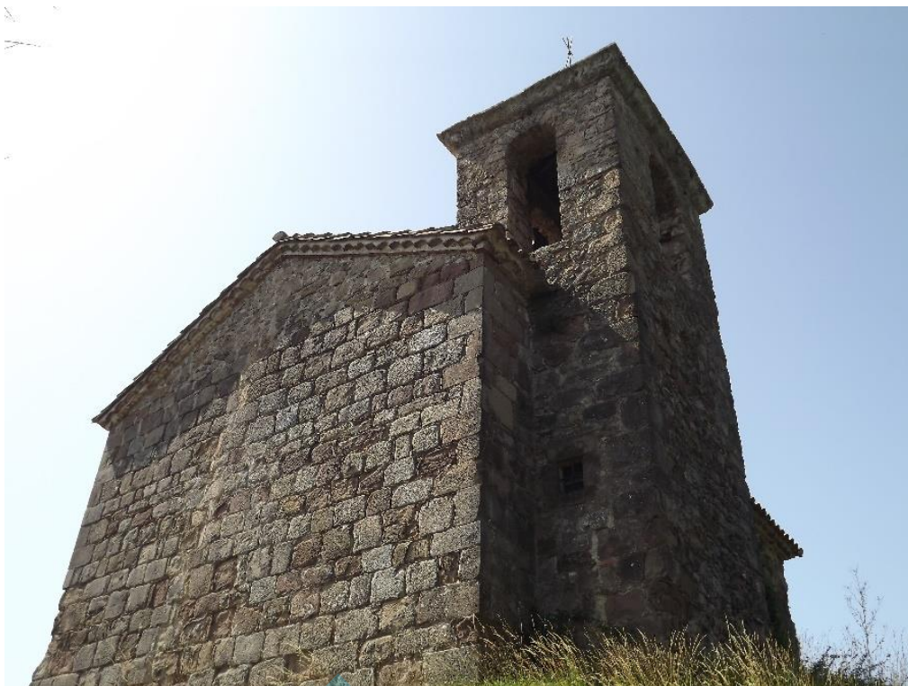
Vista general desde el suroeste
