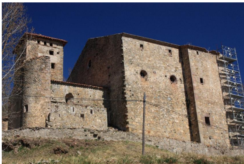
Vista general desde el lado sur
