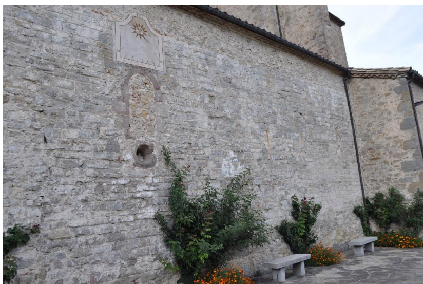
Detalle de la fachada meridional
