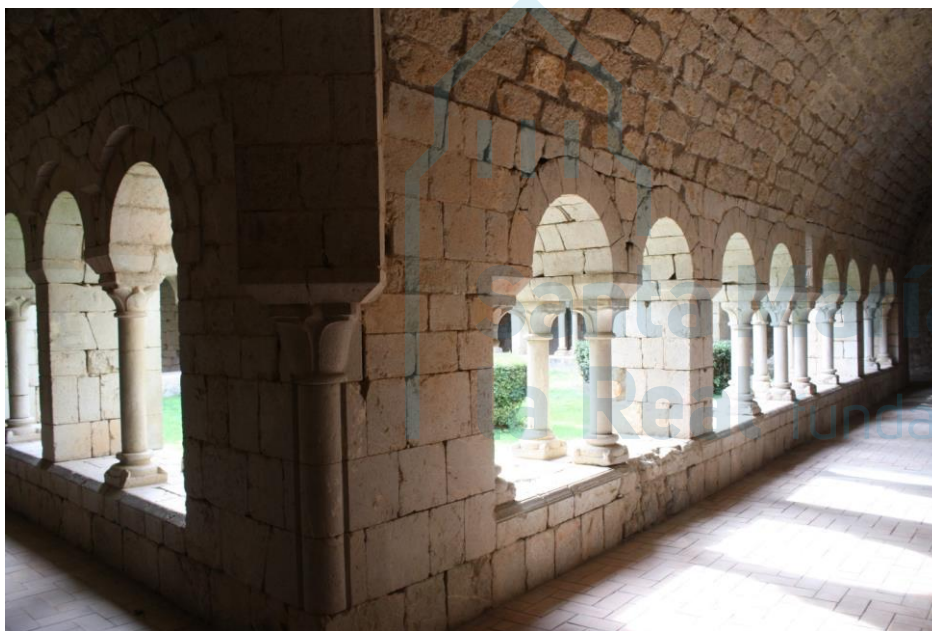
Claustro, pilar de ángulo
