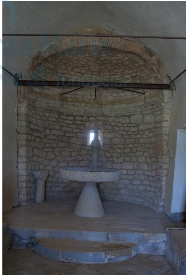
Interior del ábside
