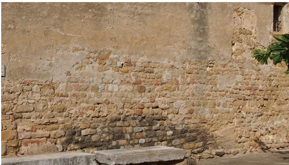
Paramento románico en la fachada sur
