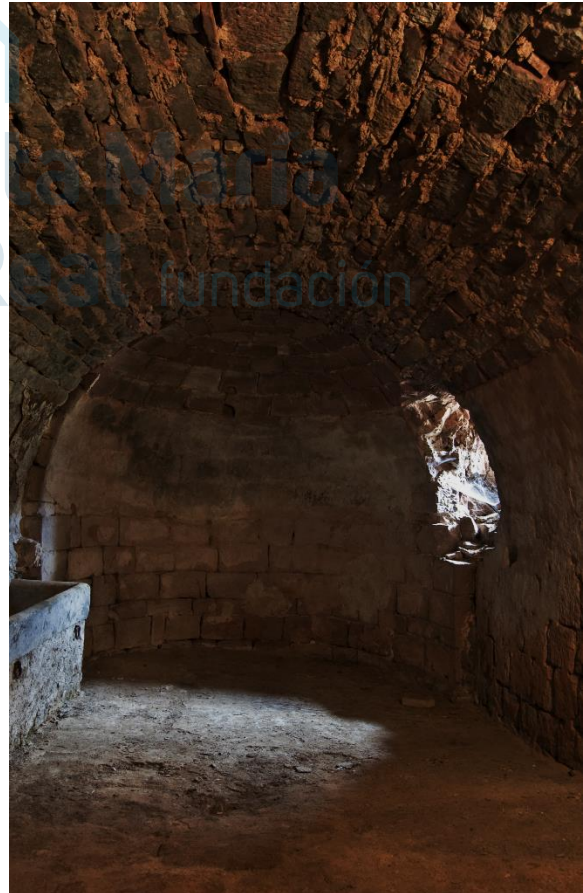
Interior de la planta inferior
