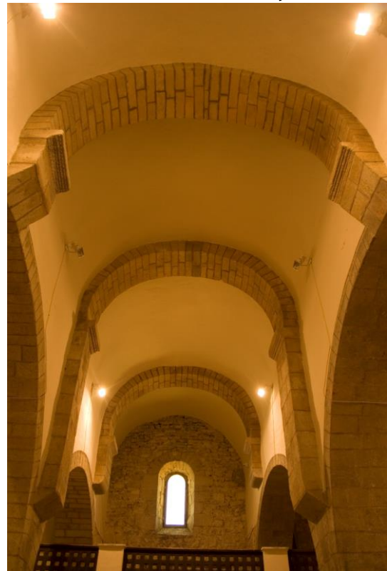
Bóveda de la nave central
