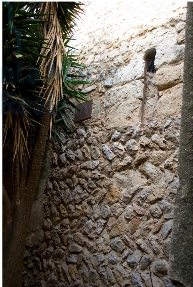
Fachada sur, paño con aparejo en opus spicatum
