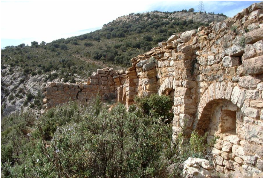
Interior del muro norte
