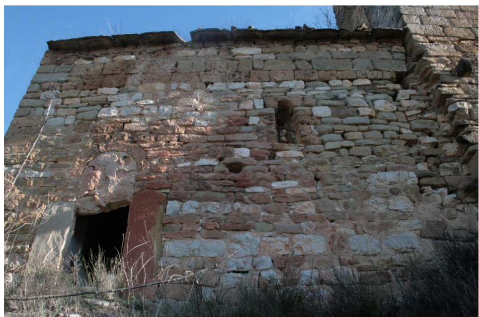
Vista exterior del muro sur
