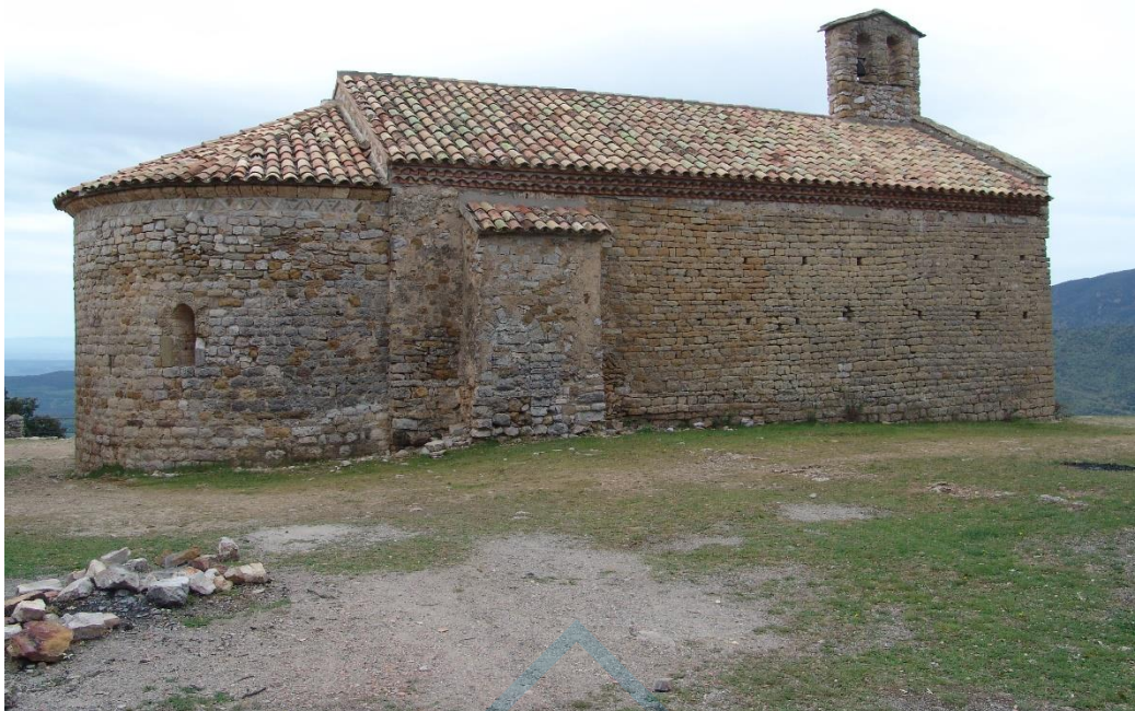
Vista general desde el norte
