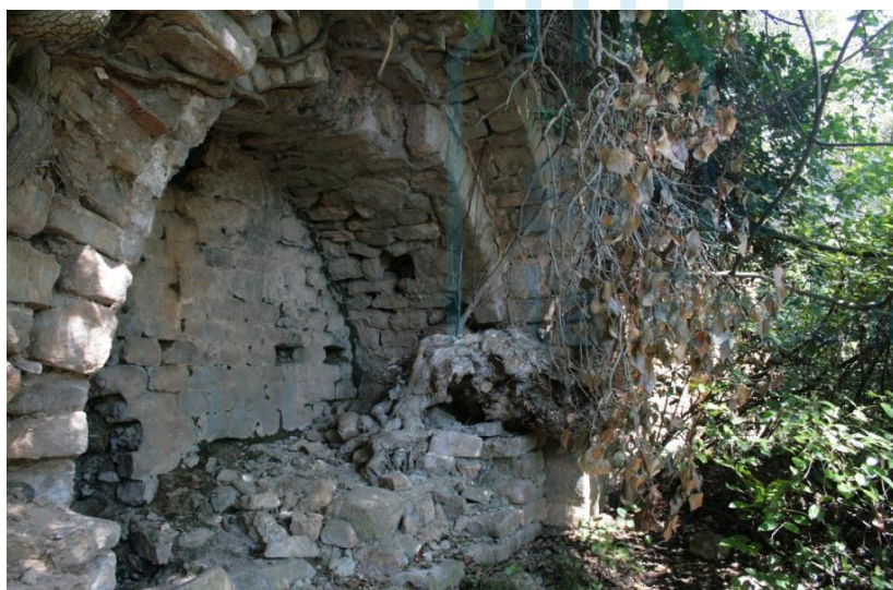
Arcos formeros del muro norte
