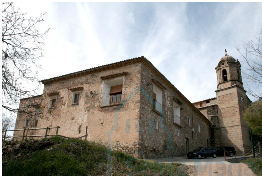
Vista general del monasterio
