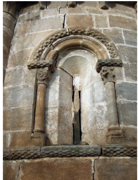
Ventana central del ábside
