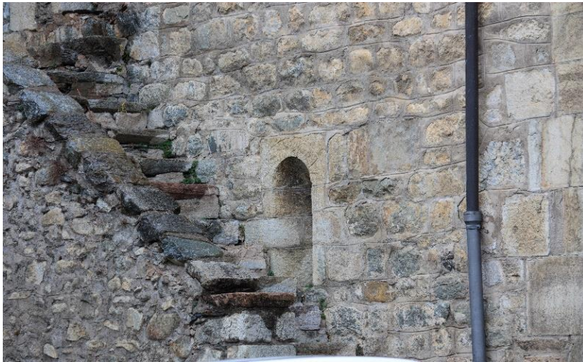
Ventana en fachada sur, junto a escalera de acceso al campanario
