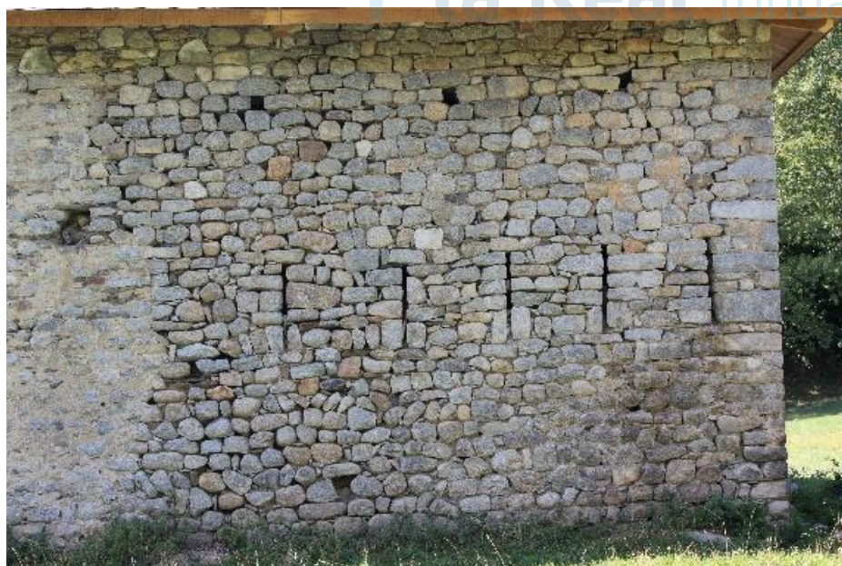
Muro con aspilleras
