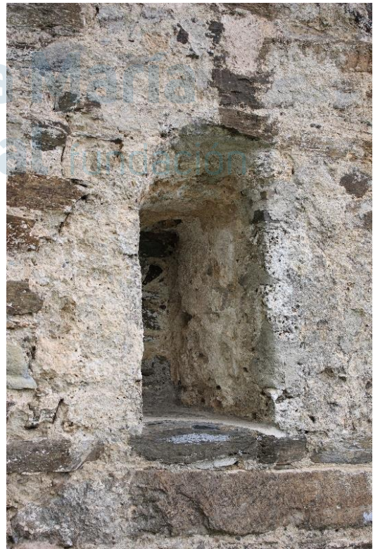
Ventana en fachada sur
