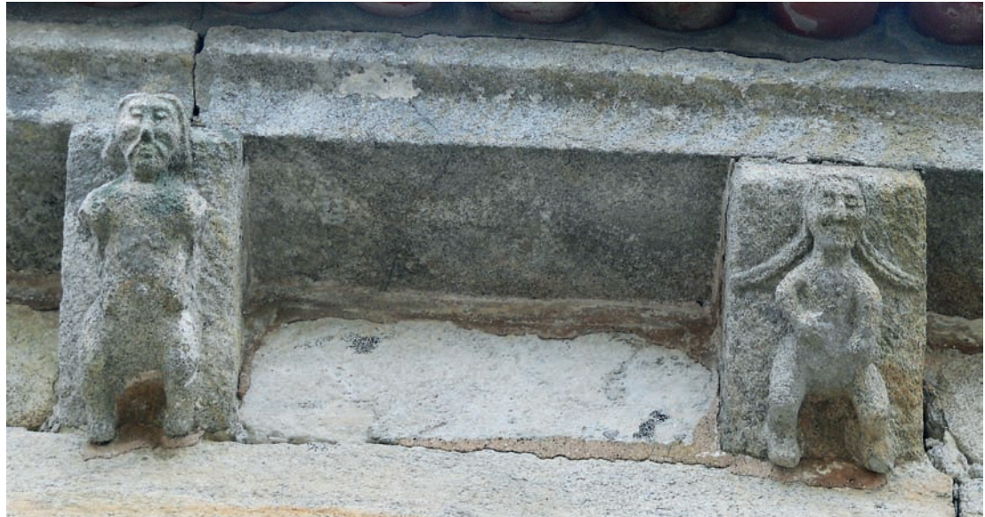
Canecillos del muro sur
