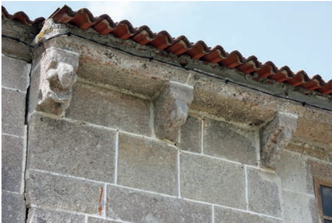
Canecillos del muro norte
