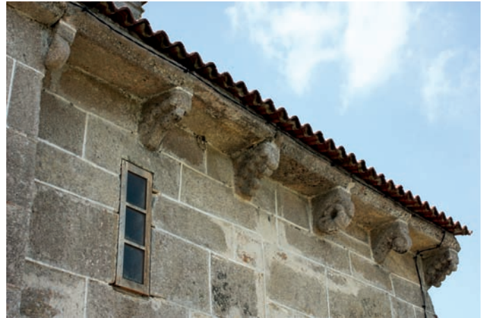
Canecillos del muro norte
