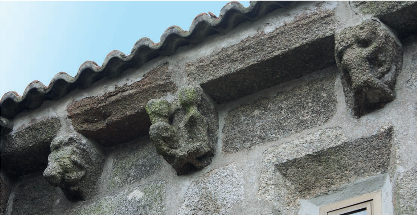
Canecillos del muro norte
