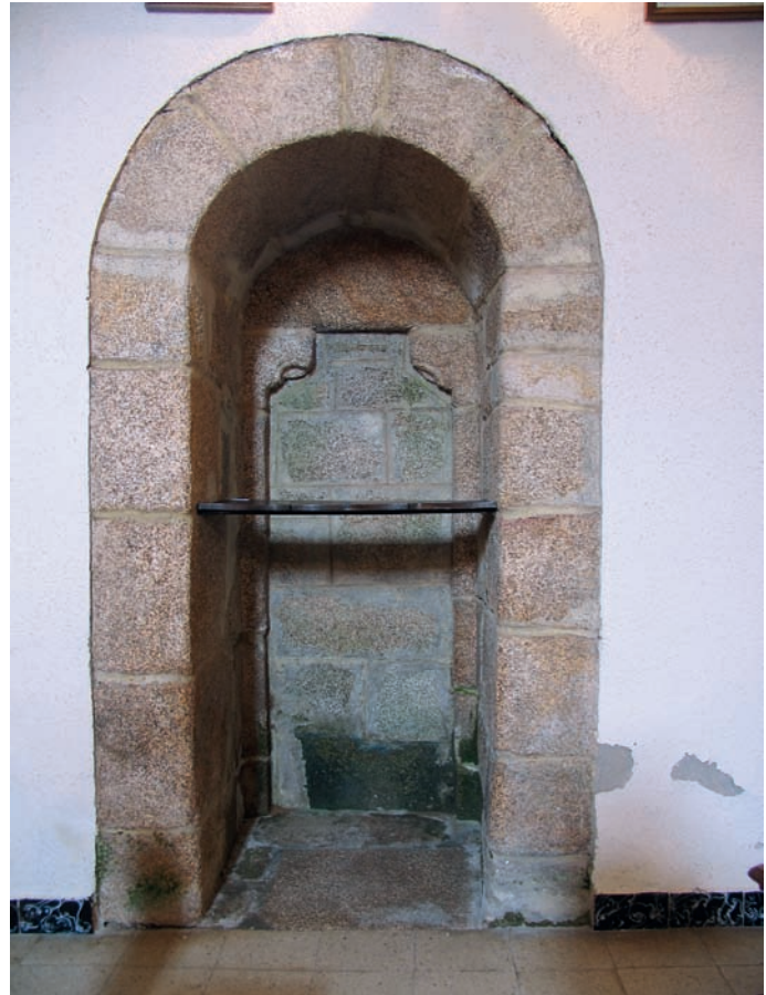
Portada cegada del muro norte
