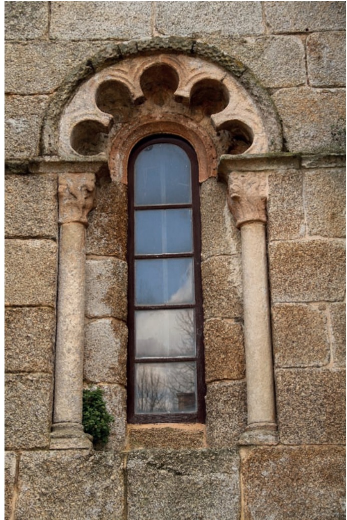
Ventana de la fachada occidental
