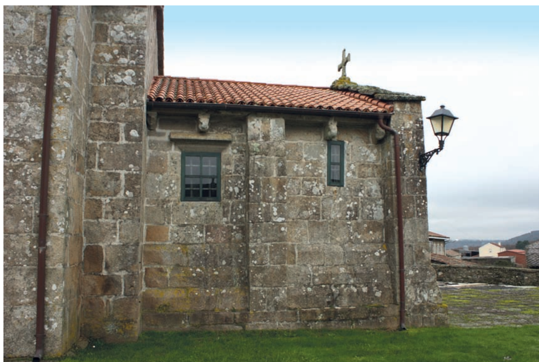
Muro sur de la cabecera
