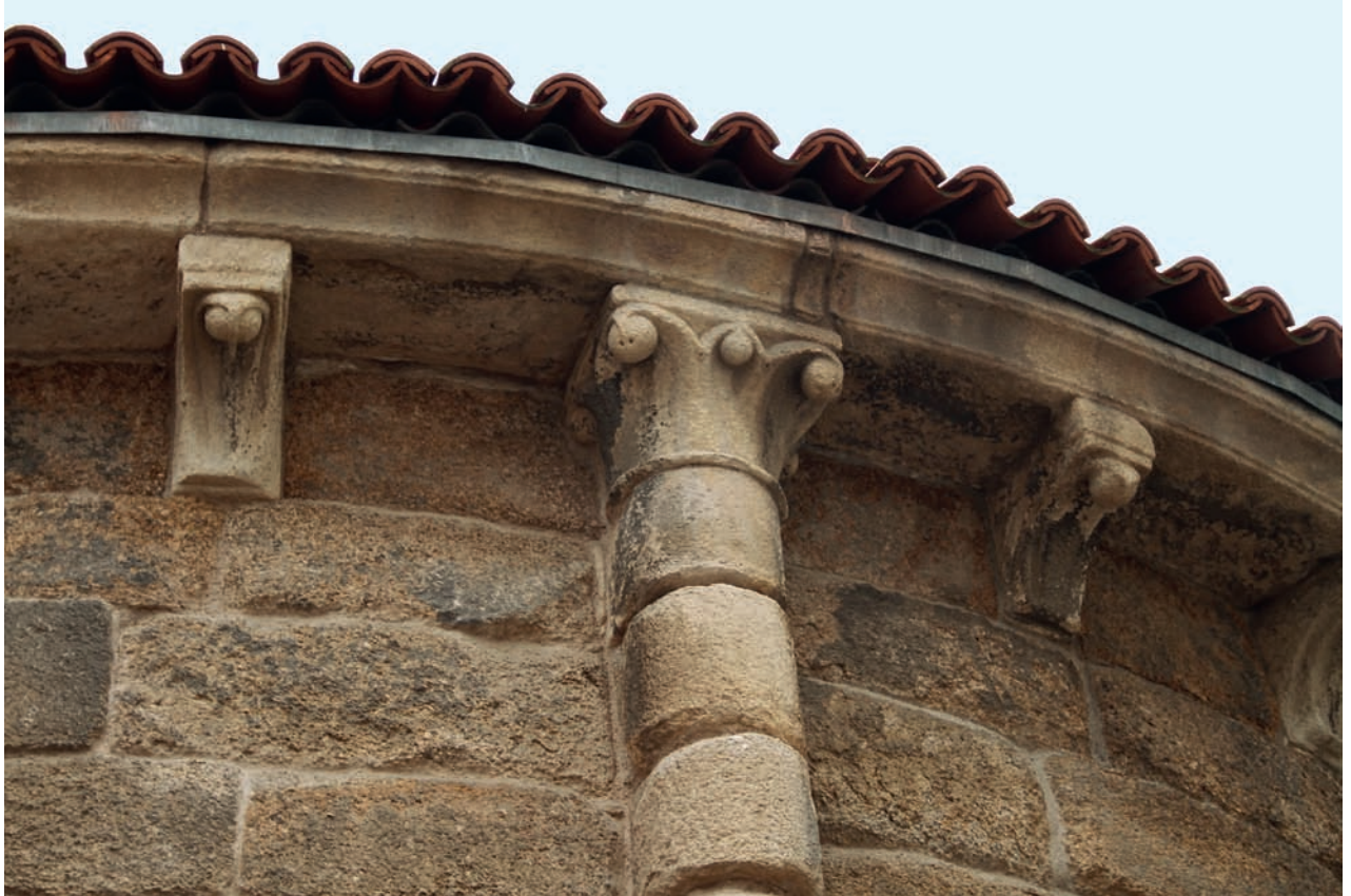
Alero del ábside
