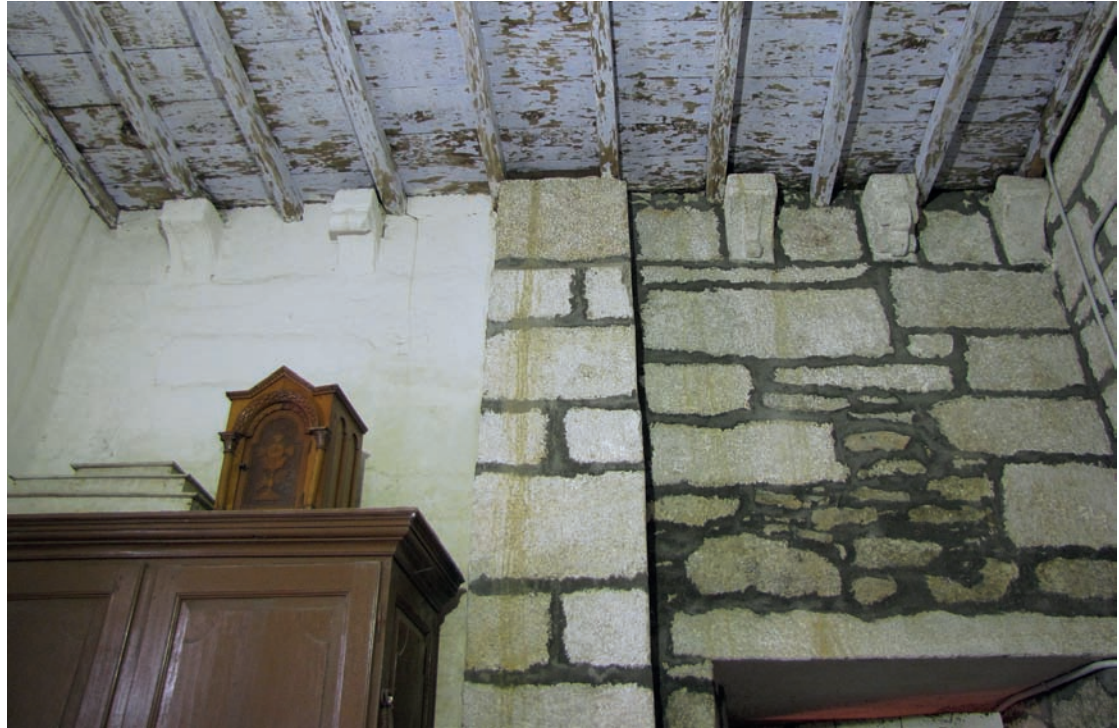
Canecillos del muro norte en el interior de la sacristía
