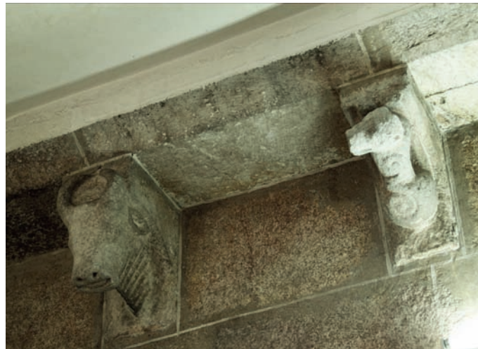
Canecillos del muro norte de la cabecera
