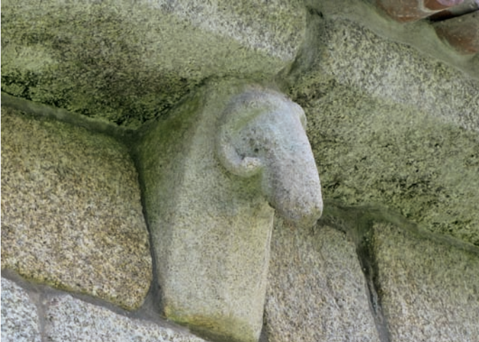
Canecillo del muro sur
