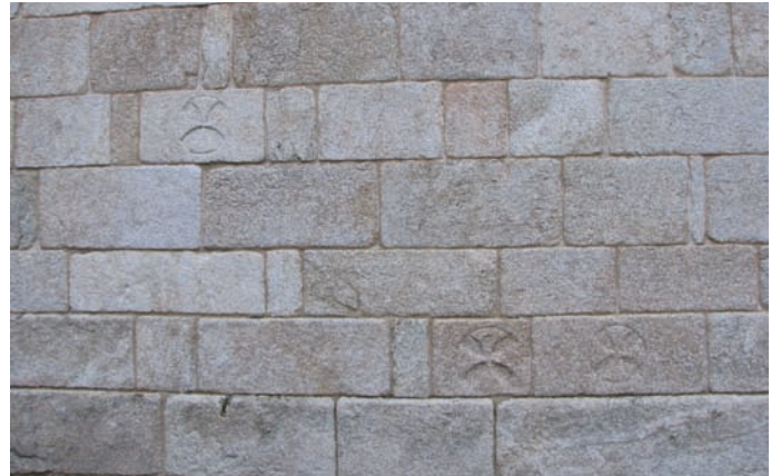
Muro de la capilla lateral con sillares románicos reutilizados
